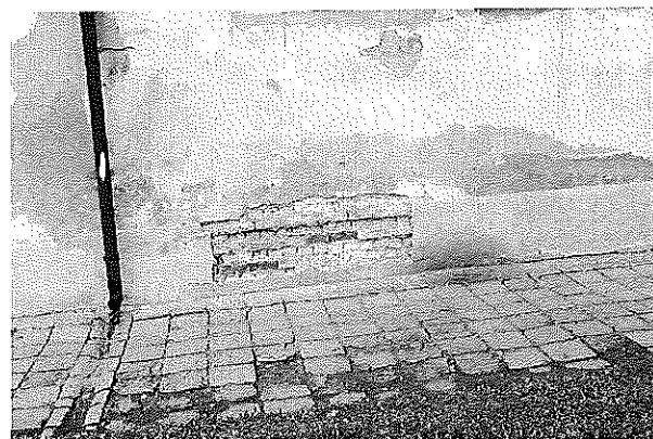
Budynek Nr 3 i 4 W dole widoczny wpływ korozji od wilgoci z taziemek
