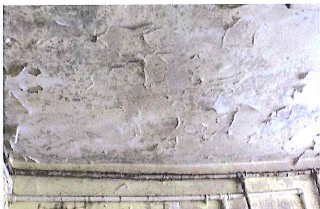
Bud.Nr 4 Skorodowana farba na sufitach łazienek oraz zacieki w narożniku
