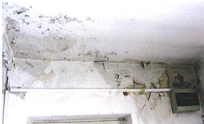
Bud.Nr 4 Skorodowana farba na sufitach łazienek oraz zacieki w narożniku
